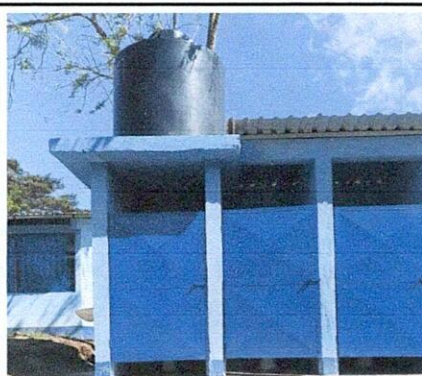
Foto 4: Mejoramiento de sanitarios y migitorio con pared de block
