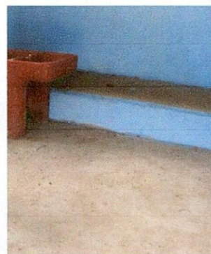
Foto 4: Mejoramiento de cocina tipo portico
