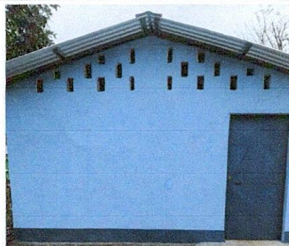
Foto 2: Mejoramiento de cocina tipo portico
