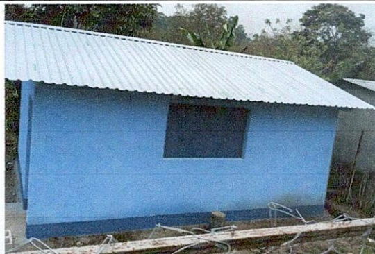
Foto1: Mejoramiento de cocina tipo portico
