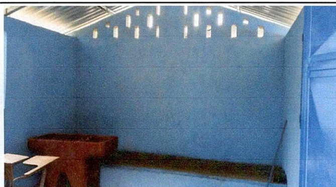
Foto 3: Mejoramiento de cocina tipo portico
